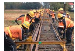
レール交換の訓練
