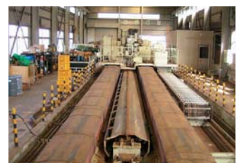
レール再生プラント
