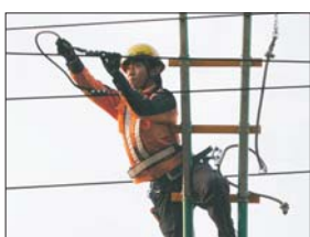
架線保守の訓練
