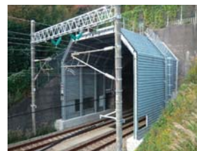
新幹線のトンネル緩衝工
