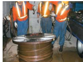
レールとまくらぎの間で列車の衝撃を緩衝するために使用しているゴムパッドをチップ化し、踏切路盤材としてリサイクルしています。(P43神戸保線区の取り組みをご覧ください。)
