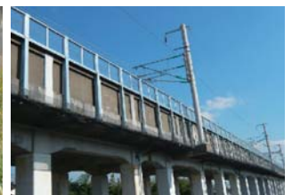
新幹線の防音壁
