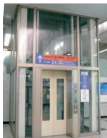
大阪駅御堂筋口エレベーター
