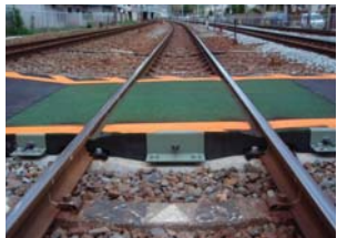
レールとまくらぎの間で列車の衝撃を緩衝するために使用しているゴムパッドをチップ化し、踏切路盤材としてリサイクルしています。(P43神戸保線区の取り組みをご覧ください。)
