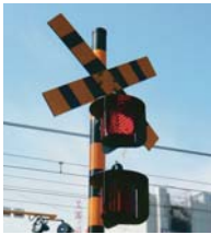
全方位型踏切警報灯
