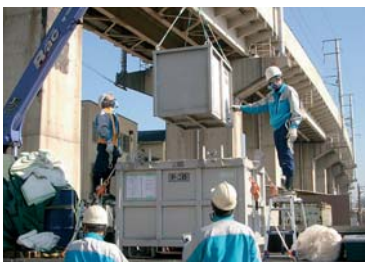
PCB搬出作業
