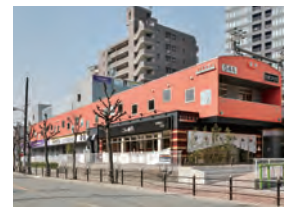
ビエラタウン玉造 所在地/大阪府大阪市 用途/商業施設 延床面積/4,125m 2 竣工/2014年3月
