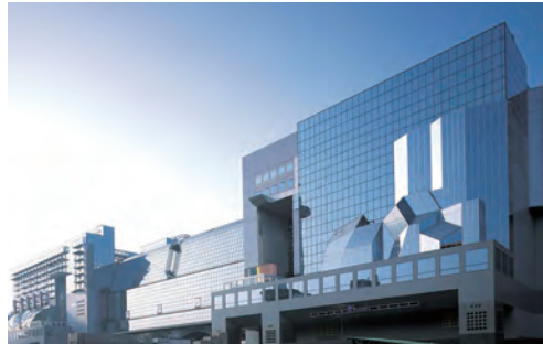
京都駅ビル 所在地/京都府京都市 用途/オフィス、商業施設、 ホテル、劇場 延床面積/約236,000m 2 開業/1997年9月
