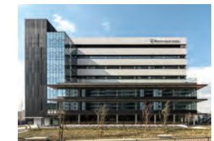
健都イノベーションパークNKビル 所在地/大阪府摂津市 用途/賃貸ラボ・オフィス、シェアラボ 延床面積/9,090m 2 竣工/2022年3月
