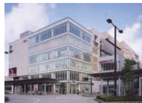
JR金沢駅NKビル 所在地/石川県金沢市 用途/商業施設 延床面積/61,124m 2 竣工/2006年11月
