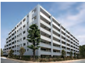
ジェイグラン甲子園口 所在地/兵庫県西宮市 用途/分譲マンション 戸数/90戸 竣工/2006年2月
